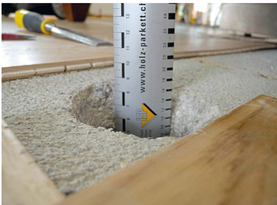
Kontrolle der Estrichdicke bei CM-Messung
