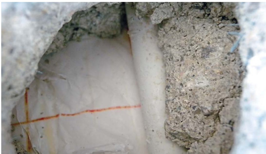
Unbeschädigtes Fussbodenheizungs-Rohr nach Spitzen eines Lochs für die CM-Messung
