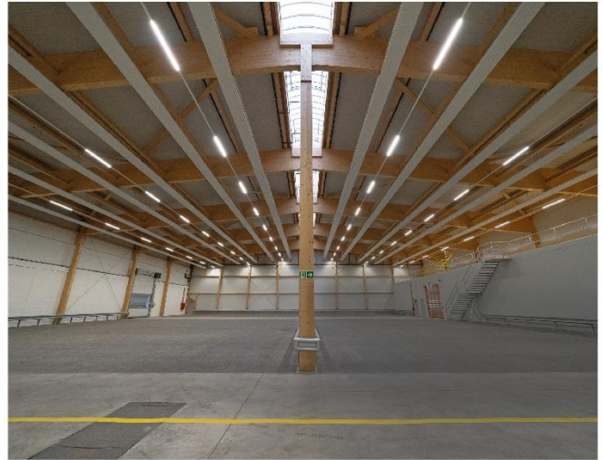
Der imposante Holzbau von innen vor Inbetriebnahme.
